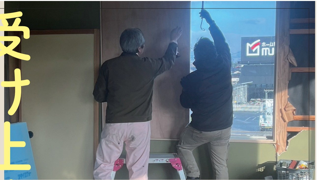
1月上旬、ライフラインがない中、外部の支援者を受け入れるために、珠洲市の街中に災害支援拠点を整備。震災で破壊された壁にベニア板を貼り付ける(写真左:暮らしくりネットワーク北芝・池谷氏、写真右:NPO法人YNF・江崎氏)。
