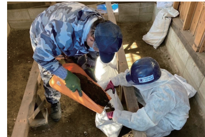
床上浸水支援(床 壁の解体と泥出し、消毒、床張り、漆喰塗りなど)
